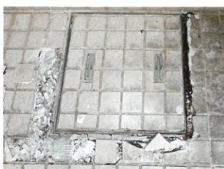
破損タイルの補修例（同じサイズと色のタイルが入手できる場合）
