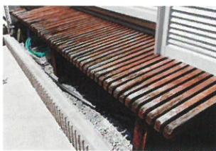
縁台の補修と塗装例（先端切断、パテ補修、保護塗装）
