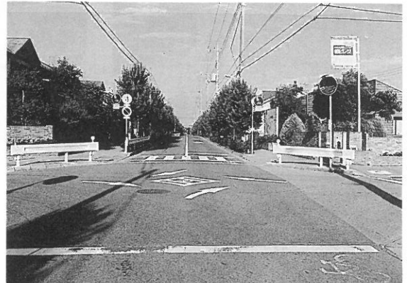
安全設備が設置された東急不動産(株)旧現地案内所前交差点全景
